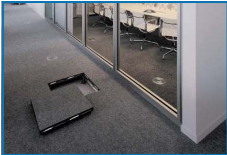
Ковровое финишное покрытие
